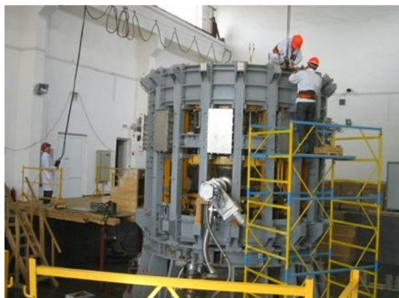
Рис. 1. Монтаж токамака КТМ (г. Курчатов, РК, 2009 г.)
